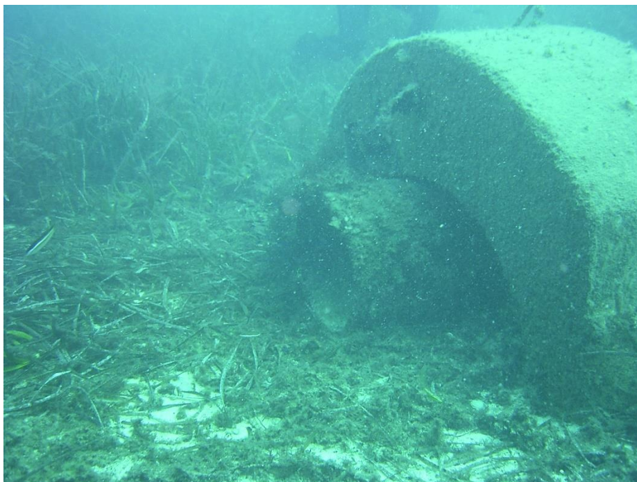
Boca del emisario situada a 21m de profundidad en pradera de Posidonia
